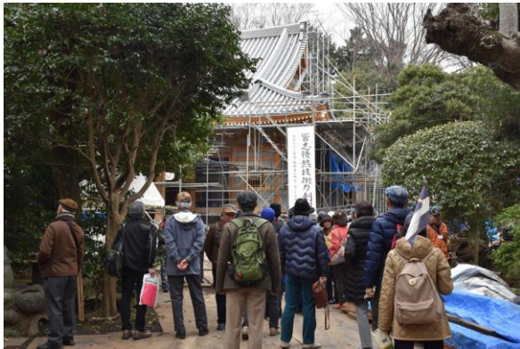
建功寺 本堂（建て替え中）
